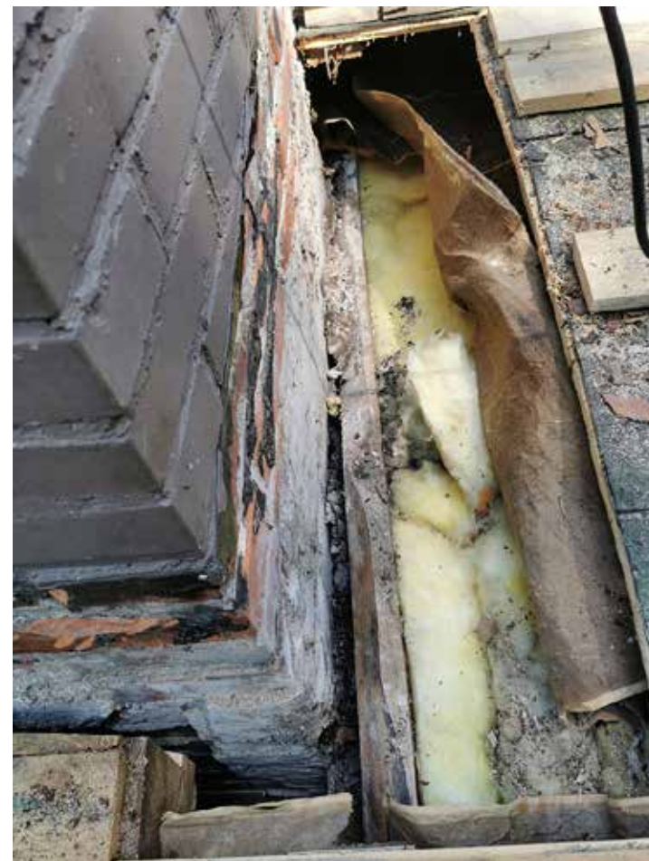
Esimerkki yläpohjarakenteiden paloeristyksestä rakennuksen savupiipun läpiviennin kohdalla. 1975 rakennettu kesämökki: kattovasat olivat kiinni savupiipussa, rappaus oli vajavainen ja palonkestävä villa puuttui. Korjauksen yhteydessä rappaus uusittiin, kattovasat siirrettiin etäämmäs, jotta niiden ja savupiipun väliin saatiin asennettua 100 mm palonkestävä kivivilla. Lisäksi piipun kunto pitää tarkastaa kokonaisuudessaan. Kuva: Anneli Velho.
