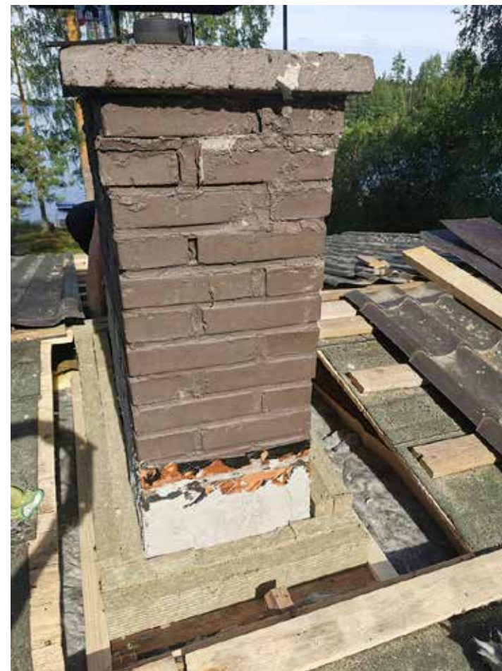
Esimerkki yläpohjarakenteiden paloeristyksestä rakennuksen savupiipun läpiviennin kohdalla. 1975 rakennettu kesämökki: kattovasat olivat kiinni savupiipussa, rappaus oli vajavainen ja palonkestävä villa puuttui. Korjauksen yhteydessä rappaus uusittiin, kattovasat siirrettiin etäämmäs, jotta niiden ja savupiipun väliin saatiin asennettua 100 mm palonkestävä kivivilla. Lisäksi piipun kunto pitää tarkastaa kokonaisuudessaan. Kuva: Anneli Velho.
